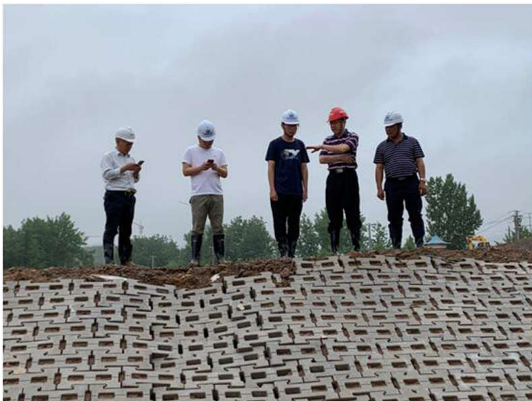
郭文增总经理检查汤逊湖泵站防汛应急工作
