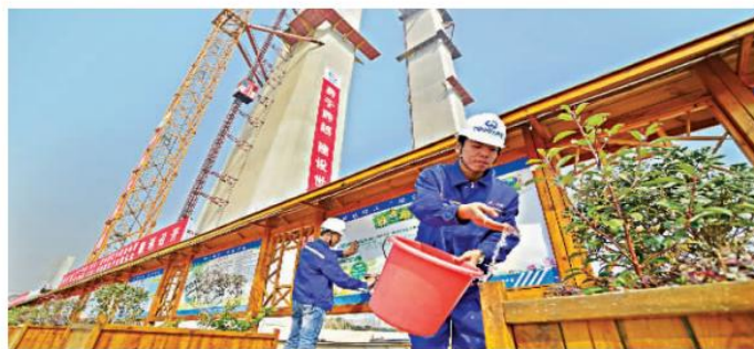
杨泗港长江大桥工地上工人在给苗木浇水 记者詹松 摄
